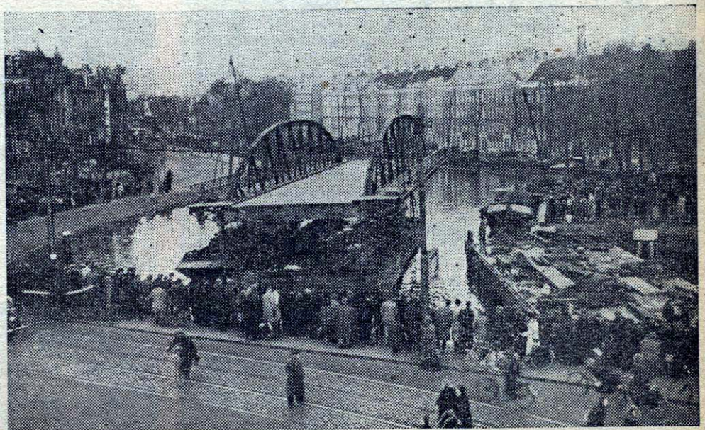
De bekende „Rotterdammer brug” over de Amsterdamse Nieuwmarkt vaart weg, om door een geheel nieuwe constructie vervangen te worden.
